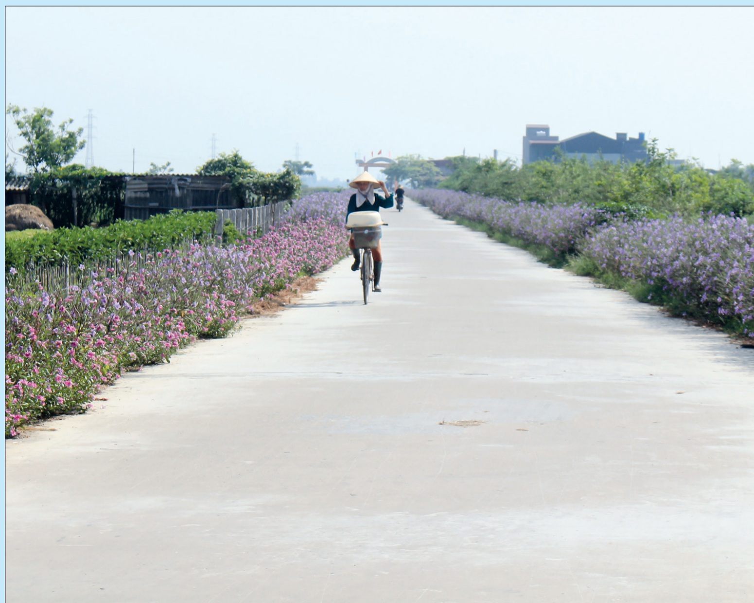
Đường giao thông nông thôn xã Việt Hùng (Vũ Thư).
