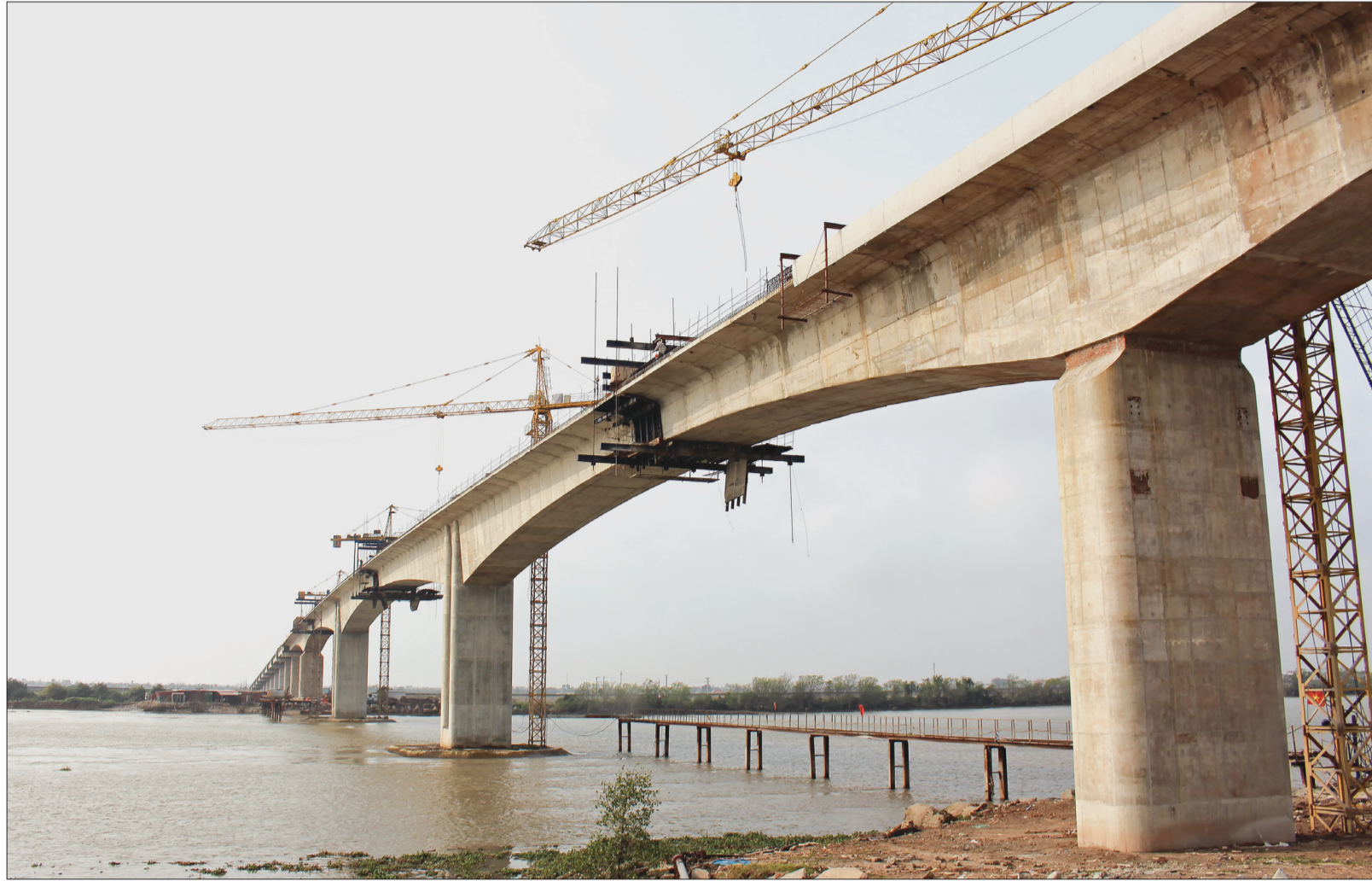
Công trình cầu vượt sông Trà Lý.
