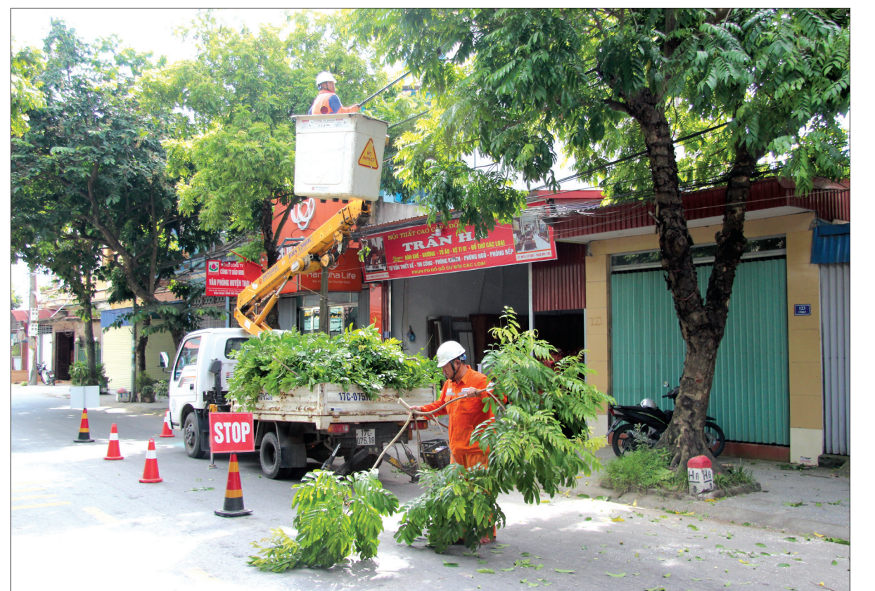
Công nhân Điện lực Thái Thụy phát quang hành lang lưới điện bảo đảm cấp điện ổn định trong mùa mưa bão.
