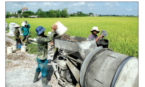
Làm đường giao thông nội đồng ở xã Vũ Công (Kiến Xương).
