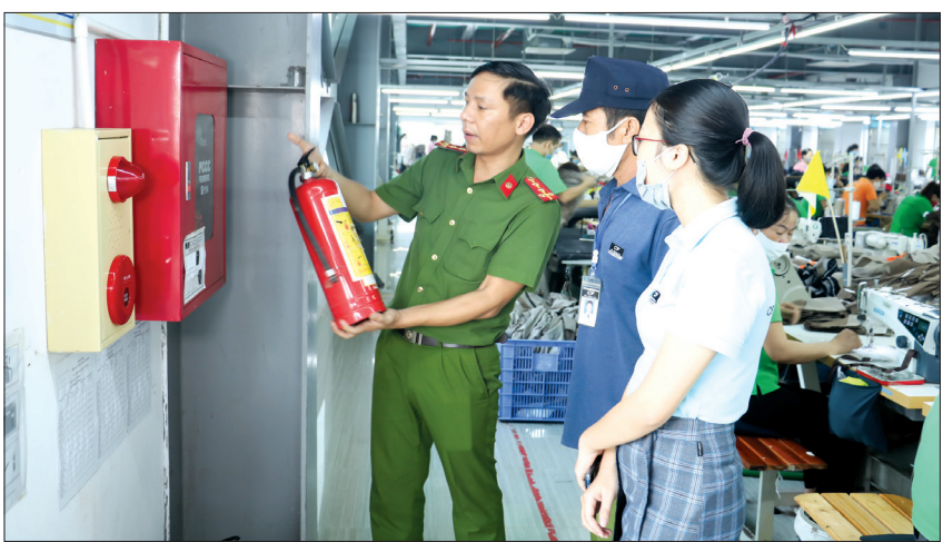
Lực lượng cảnh sát phòng cháy, chữa cháy Công an tỉnh kiểm tra công tác phòng, chống cháy, nổ tại Công ty Cổ phần C.F toàn cầu Thái Bình.
