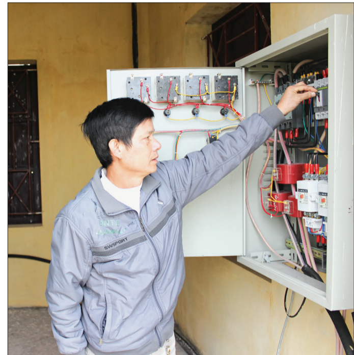
HTX SXKD DVNN xã Vân Trường (Tiên Hải) kiểm tra các trạm bơm bảo đảm vận hành phục vụ sản xuất vụ xuân.
