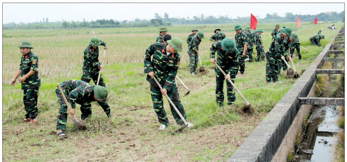
Cán bộ, chiến sĩ Ban Chỉ huy Quân sự huyện Đông Hưng tham gia dọn cỏ tạo mặt bằng để bê tông hóa đường giao thông nội đồng tại xã Lô Giang.
