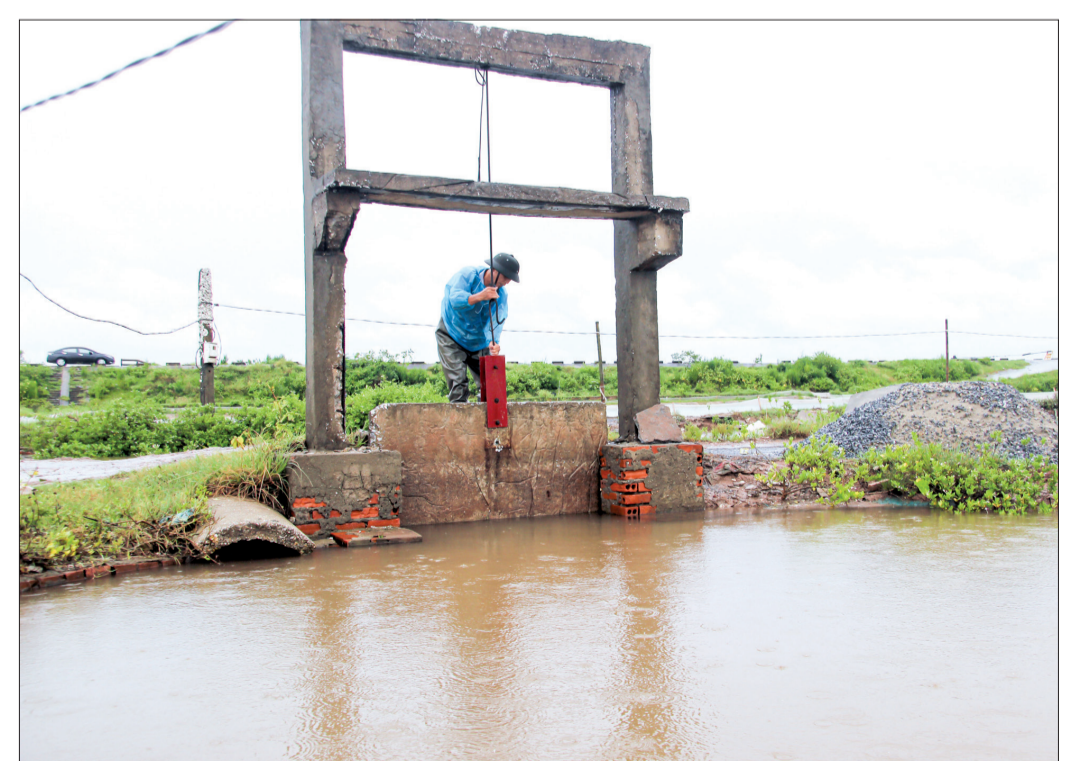
Các cống đầu khâu tại vùng nuôi trồng thủy sản xã Nam Cường được gia cố bảo đảm lấy nước phục vụ nuôi trồng thủy sản.
