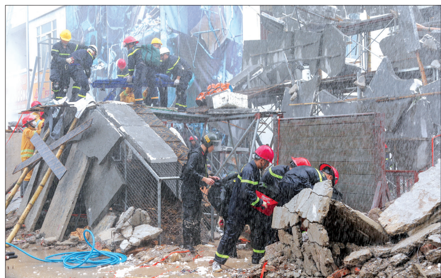
Các lực lượng tìm kiếm vị trí nạn nhân mắc kẹt và tổ chức cứu hộ trong nội dung diễn tập xử trí tình huống sập đổ công trình.
