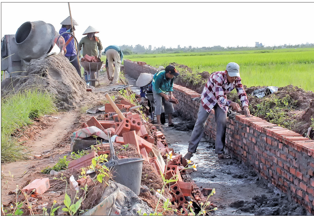
Xã Thái Hòa (Thái Thụy) xây dựng hệ thống thủy lợi nội đồng.
