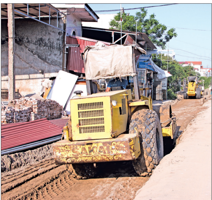
Thi công quốc lộ 39 đoạn qua địa bàn xã Phúc Khánh.
