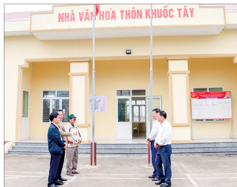
Đoàn kiểm tra thực tế tại nhà văn hóa thôn Khuốc Tây, xã Phong Châu (Đông Hưng).
