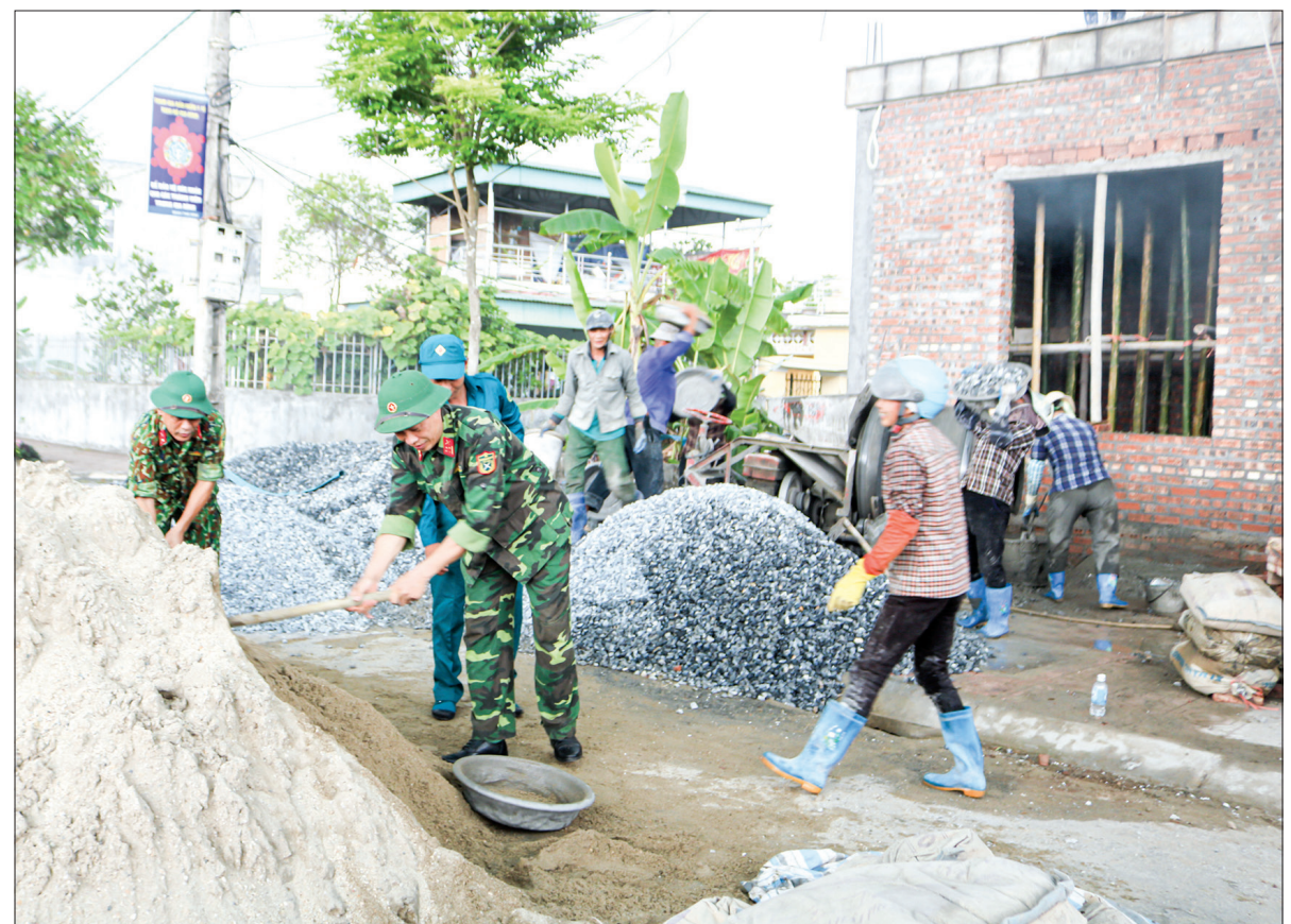
Cán bộ, chiến sĩ Ban CHQS thành phố Thái Bình tham gia xây dựng nhà tình nghĩa cho bà Nguyễn Thị Vạnh.
