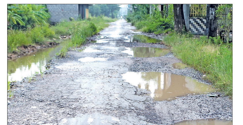
Đường vốn nhỏ, hẹp, xuống cấp, từ khi bị đào một bên đường tạo thêm phần nguy hiểm cho người tham gia giao thông.
