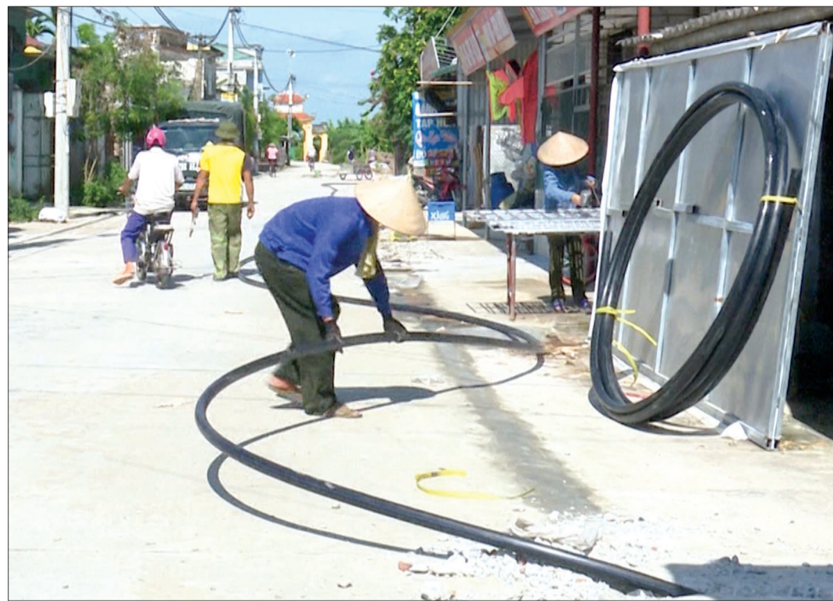
Thi công đường ống cấp nước của Công ty Cổ phần Casaro miền Bắc.
