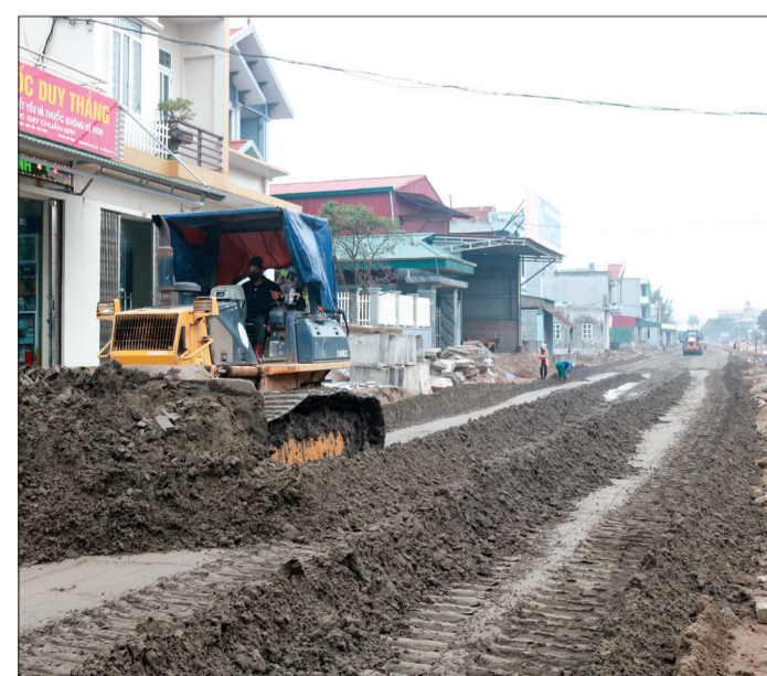
Thi công tuyến đường 221A.
