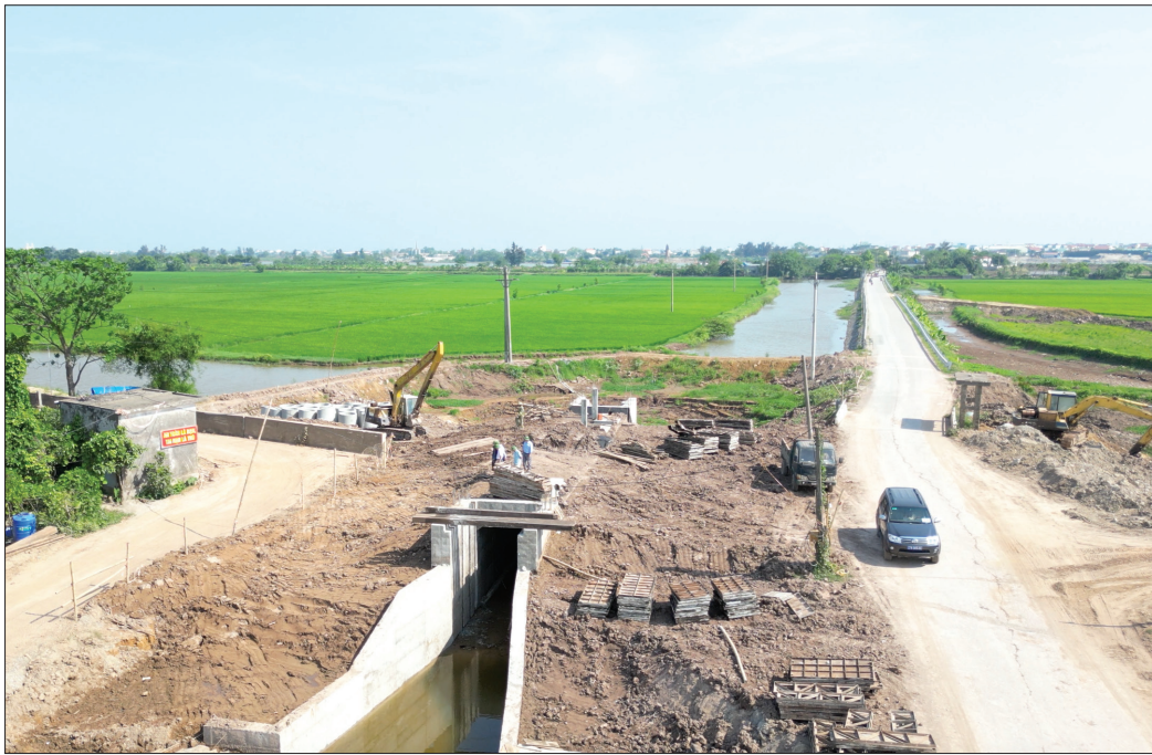
Cống Thanh Niên đã hoàn thành thi công phần thân cống và tường cánh thượng, hạ lưu.
