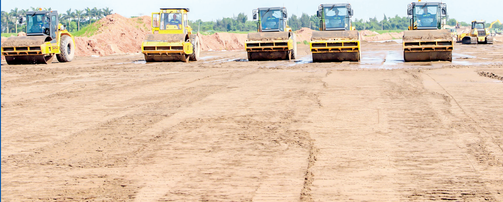
Thí công tuyến đường số 3 thuộc dự án đầu tư xây dựng các tuyến đường trục kết nối các khu chức năng trong Khu kinh tế Thái Bình đoạn qua địa phận huyện Tiền Hải.
