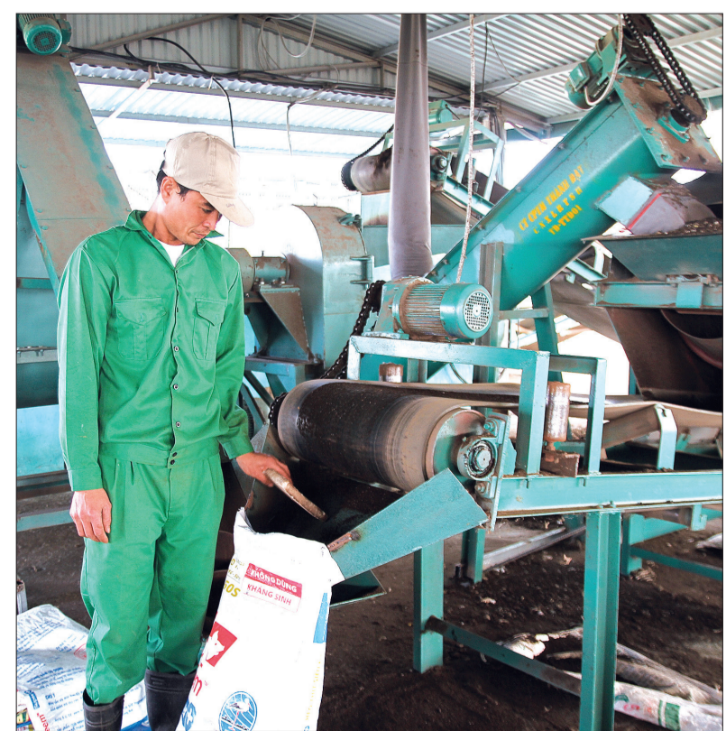
Dây chuyền chế biến phân vi sinh tại nhà máy xử lý rác sinh hoạt thị trấn Quỳnh Côi (Quỳnh Phụ).
