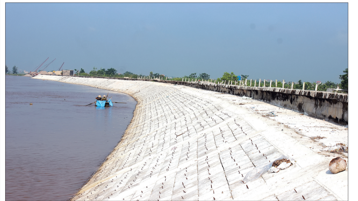
Hệ thống kè tại tuyến đê xã Nam Hải.
