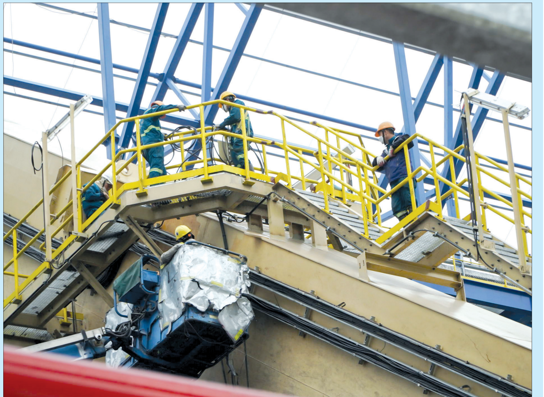
Cán bộ, công nhân trên công trường thi công kho, cảng chuyên dụng và băng tải than của Nhà máy nhiệt điện Thái Bình 2.
