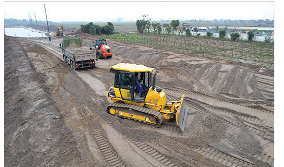
Thi công đào đắp nền đường tại tuyến số 1 đoạn qua khu công nghiệp Liên Hà Thái.
