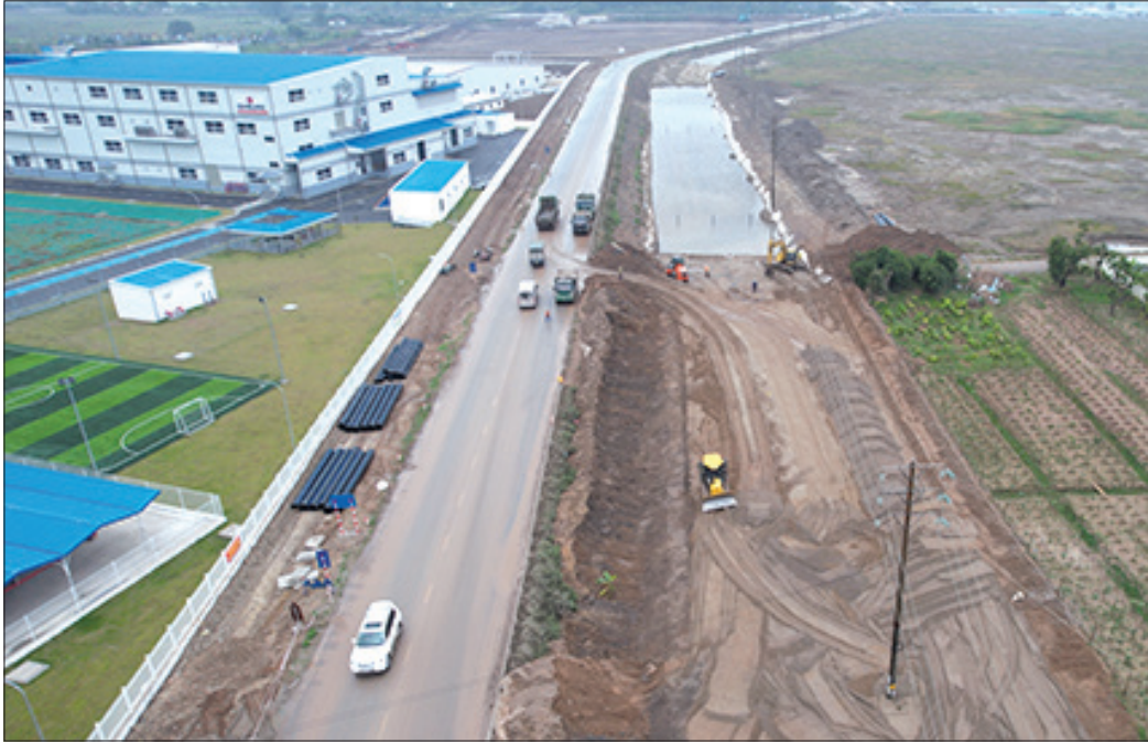
Các tuyến đường trục kết nối tạo động lực thu hút đầu tư vào Khu kinh tế.
