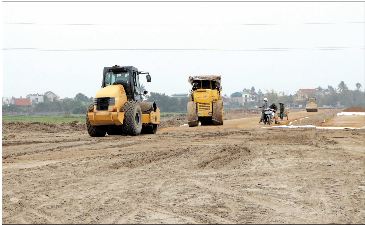
Thi công hạ tầng cụm công nghiệp Bình Minh (Kiến Xương).
