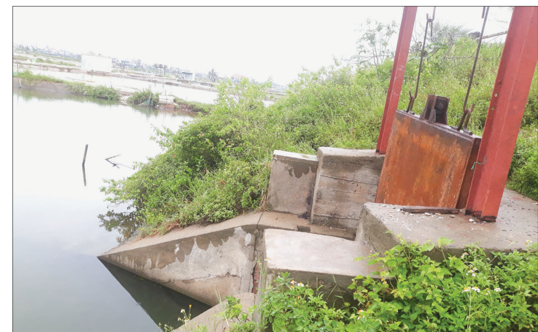
Phân tường cánh và thân cống Thoái (Tiền Hải) đã bị nứt gãy, hư hỏng nghiêm trọng.
