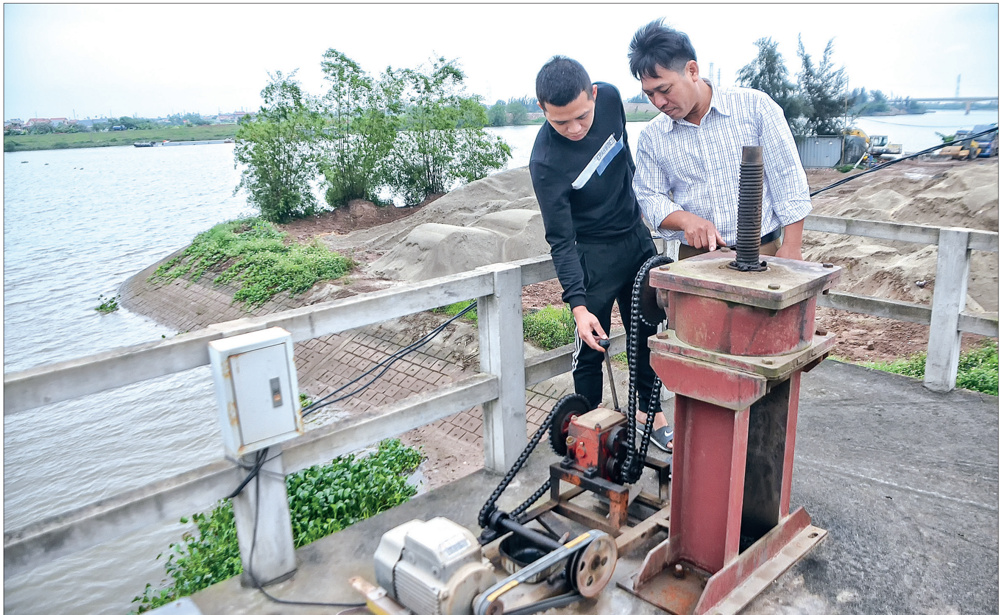
Anh Trần Trọng Kim (người bên phải) hướng dẫn thủ công Đại Hoàng, xã Tây Lương (Tiền Hải) cách vận hành máy nâng hạ cánh cổng bằng động cơ điện một pha.
