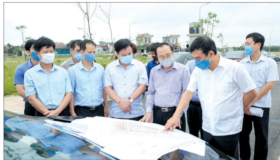
Đồng chí Đặng Trọng Thăng, Phó Bí thư Tỉnh ủy, Chủ tịch UBND tỉnh kiểm tra tiến độ xây dựng khu tái định cư tại thôn Lương Cầu, xã An Cầu (Quỳnh Phụ). Ảnh: MINH ĐỨC
