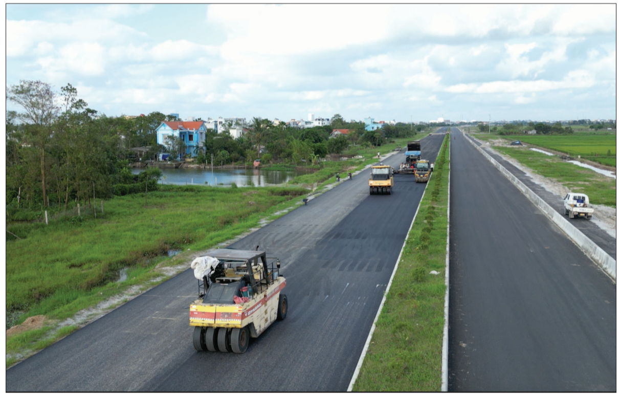
Thảm bê tông nhựa đường vành đai phía Nam thành phố Thái Bình.
