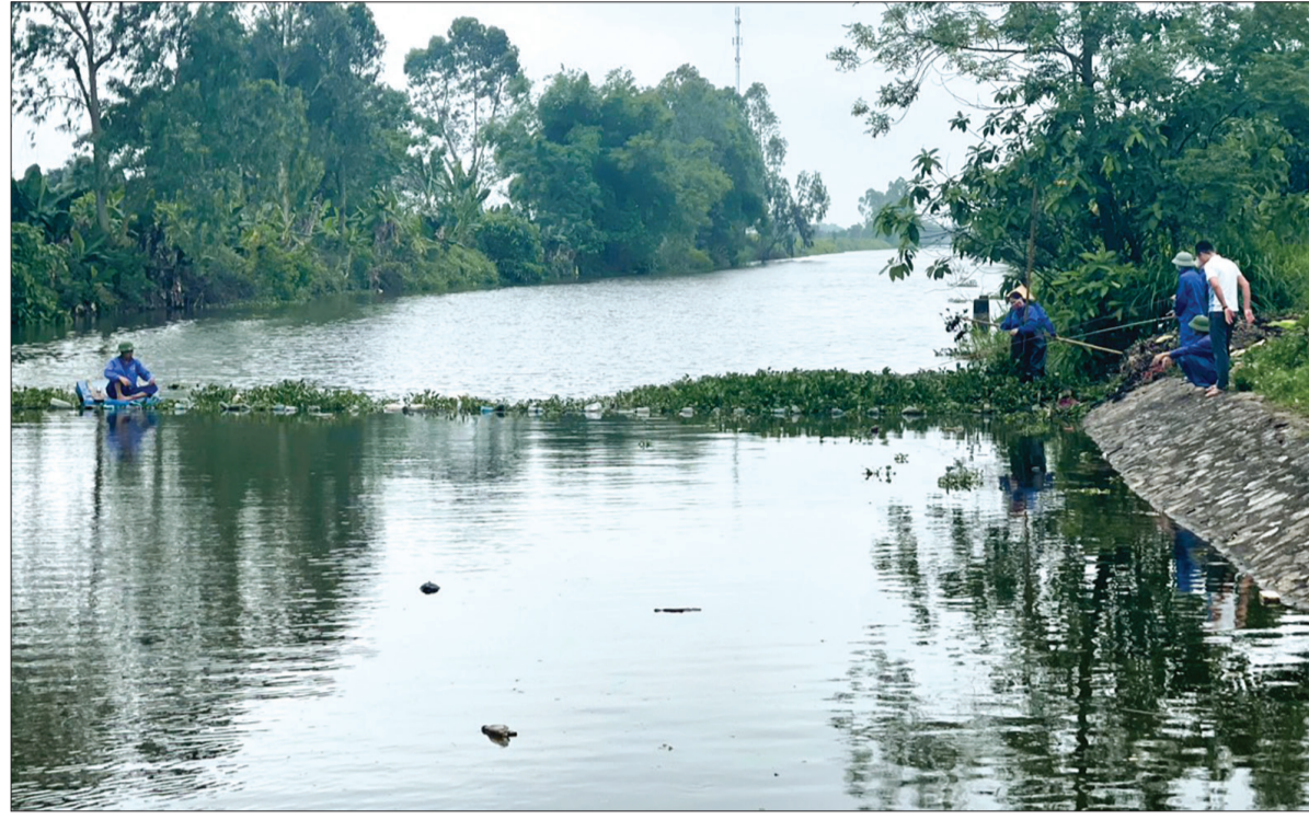
Xí nghiệp Khai thác công trình thủy lợi huyện Hưng Hà tổ chức vớt bèo bọng, khơi thông dòng chảy.
