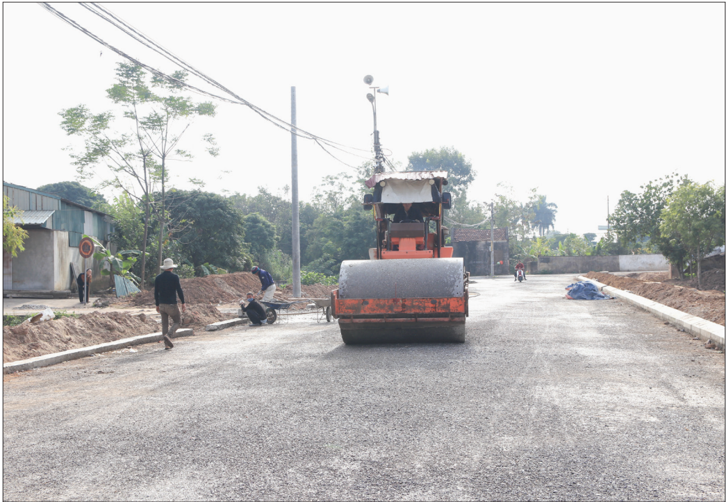
Thi công hạng mục cấp phối đá dăm, lu nền tuyến đường đến trung tâm xã Vũ Đông, đoạn từ đường Trần Lãm qua thôn Tam Lạc, xã Vũ Lạc đến xã Vũ Đông.
