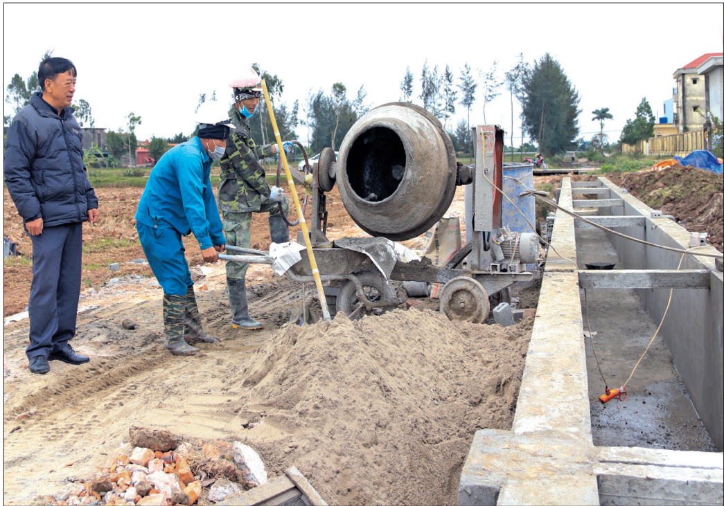
Tuyến kênh tại xã Bắc Hải (Tiền Hải) dự kiến hoàn thành đầu năm 2024.
