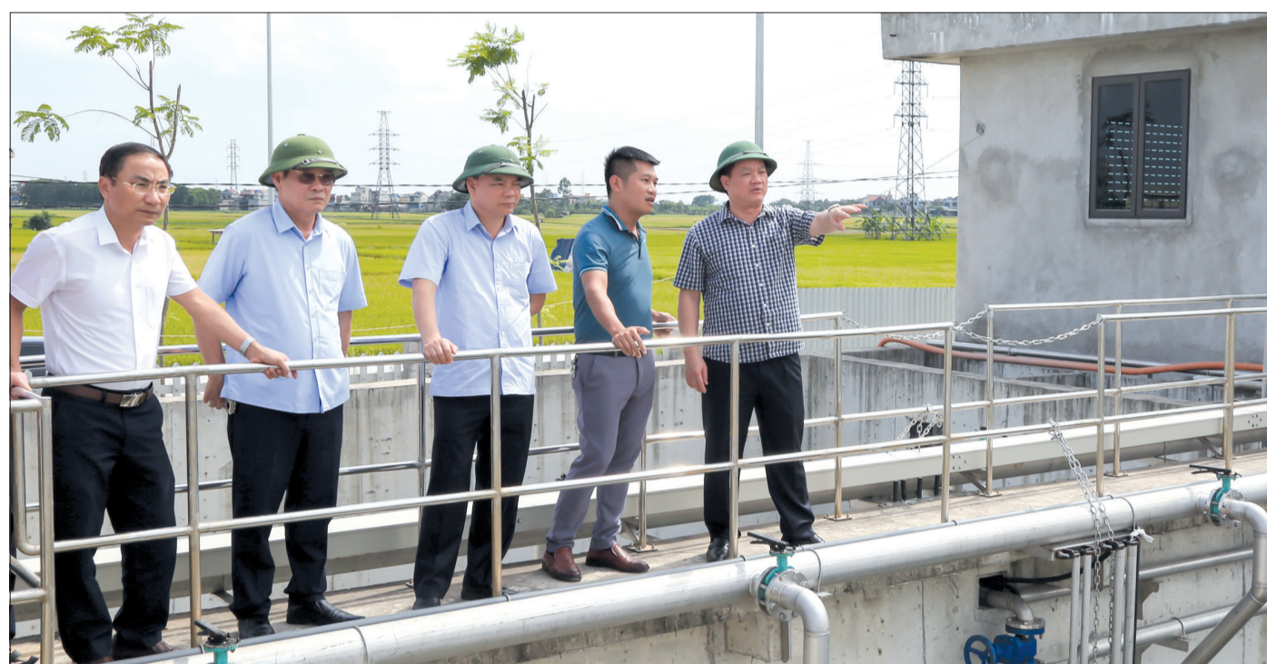
Đổng chí Nguyễn Khắc Thịnh, Phó Bí thư Tỉnh ủy, Chủ tịch UBND tỉnh kiểm tra tiến độ đầu tư xây dựng trạm xử lý nước thải tại cụm công nghiệp Đông La (Đông Hưng). Ảnh: THÀNH TÂM
