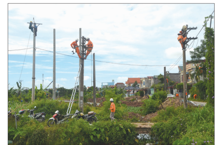
Điện lực Quỳnh Phụ tổ chức di dời cột điện tại xã Quỳnh Mỹ.
