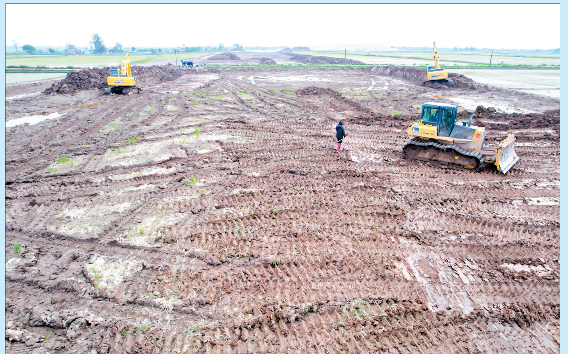
Thi công đào đắp nền đường tại tuyến số 3 đoạn qua địa phận xã Nam Hải (Tiên Hải).
