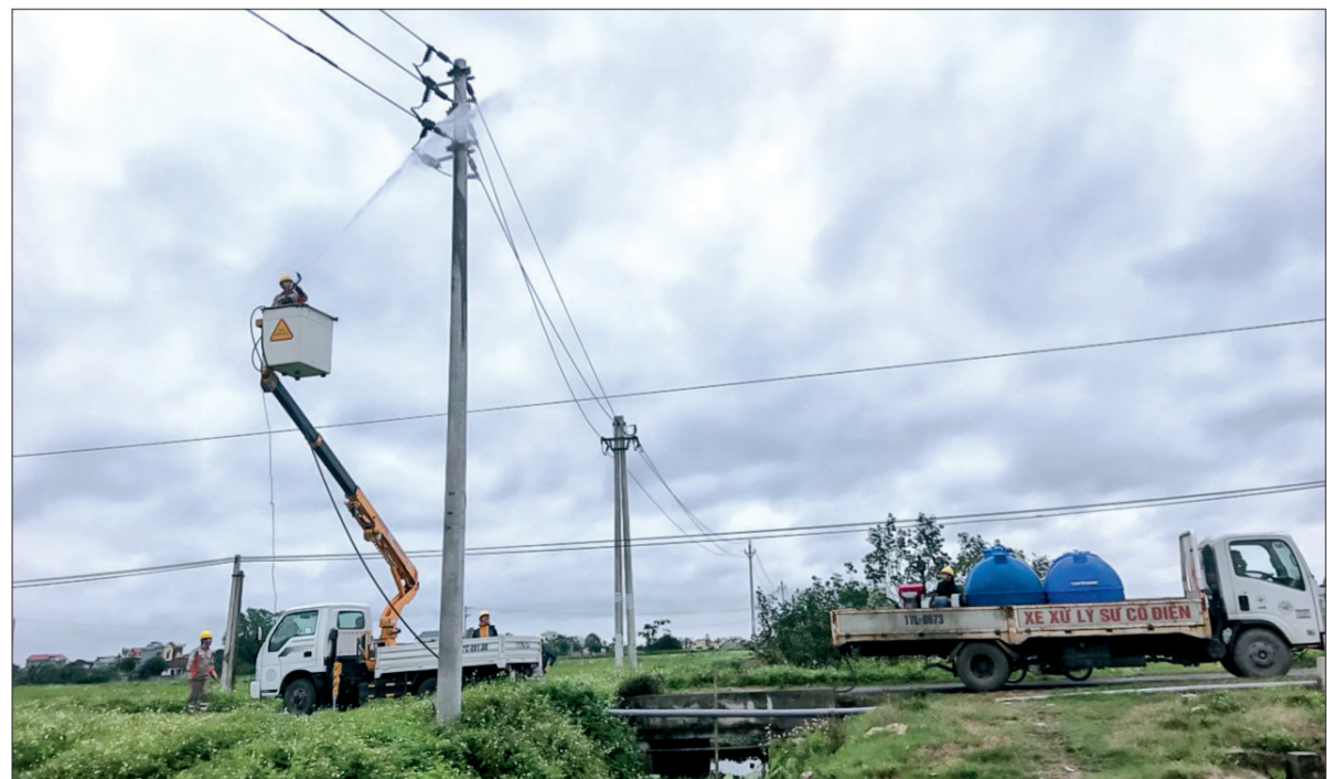
Điện lực Kiến Xương vệ sinh cách điện đường dây trung áp đang mang điện tại xã Trà Giang (Kiến Xương).
