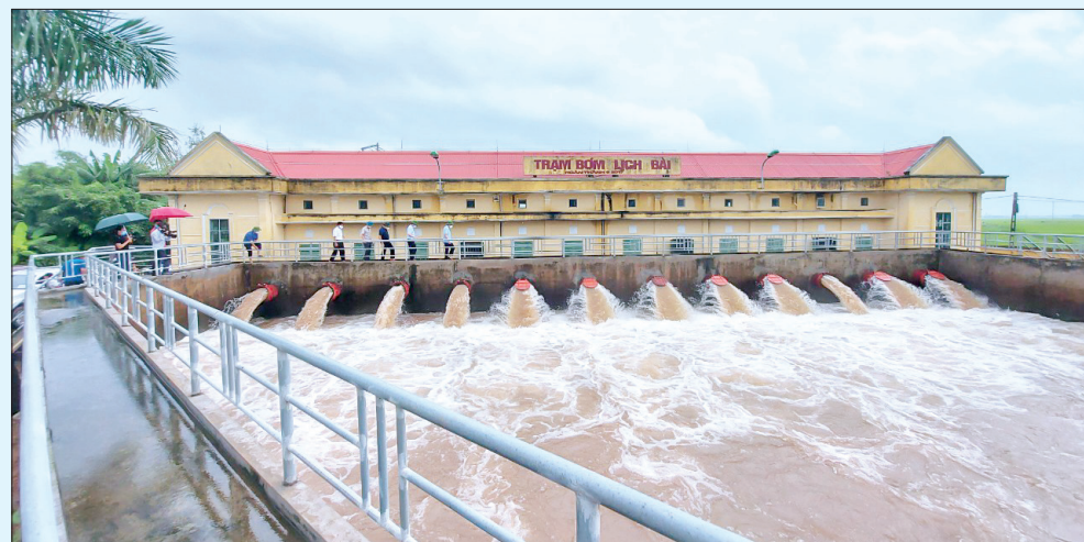
Trạm bơm Lịch Bài (xã Vũ Hòa, huyện Kiến Xương) hoạt động hết công suất để tiêu úng cho lúa và cây màu.
