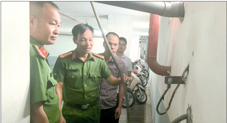
Kiểm tra hệ thống tiếp đất chống sét của tòa nhà.
