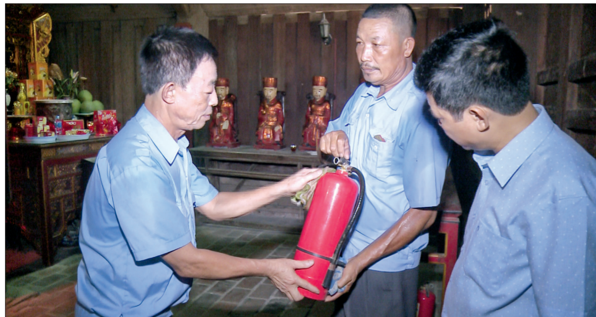
Lực lượng phòng cháy, chữa cháy tại chùa Keo kiểm tra, vệ sinh thiết bị phòng cháy, chữa cháy.
