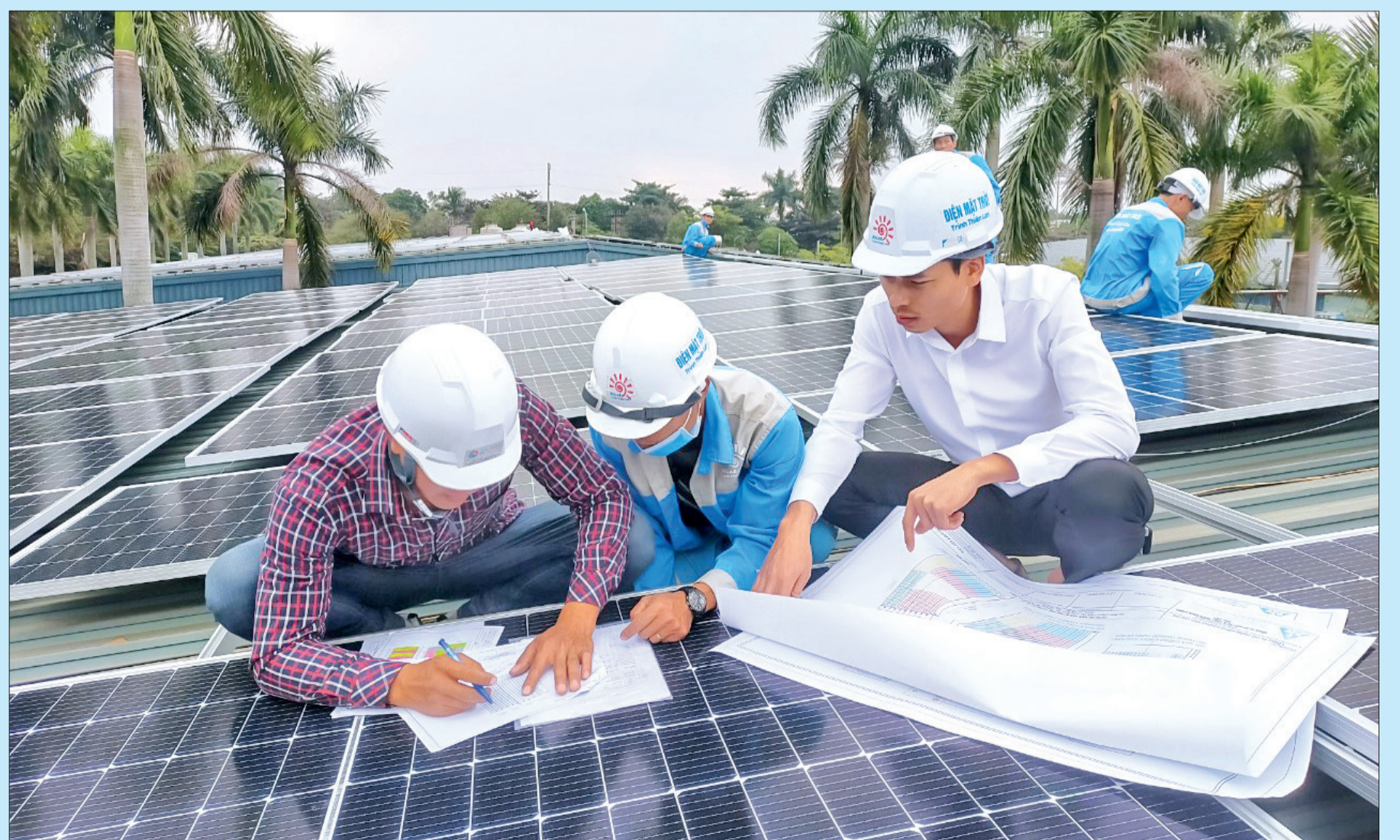
Công ty TNHH Trang trí nội thất và Năng lượng xanh Trinh Thiên Lan tập trung đẩy nhanh tiến độ thi công công trình.
