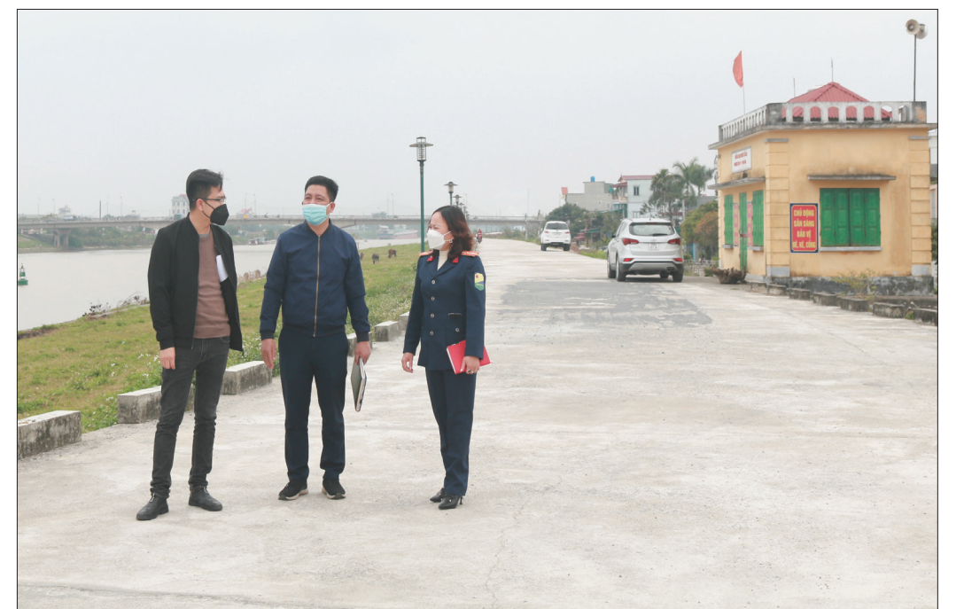
Tuyến đê tả Trà Lý địa phận phường Hoàng Diệu (thành phố Thái Bình).
