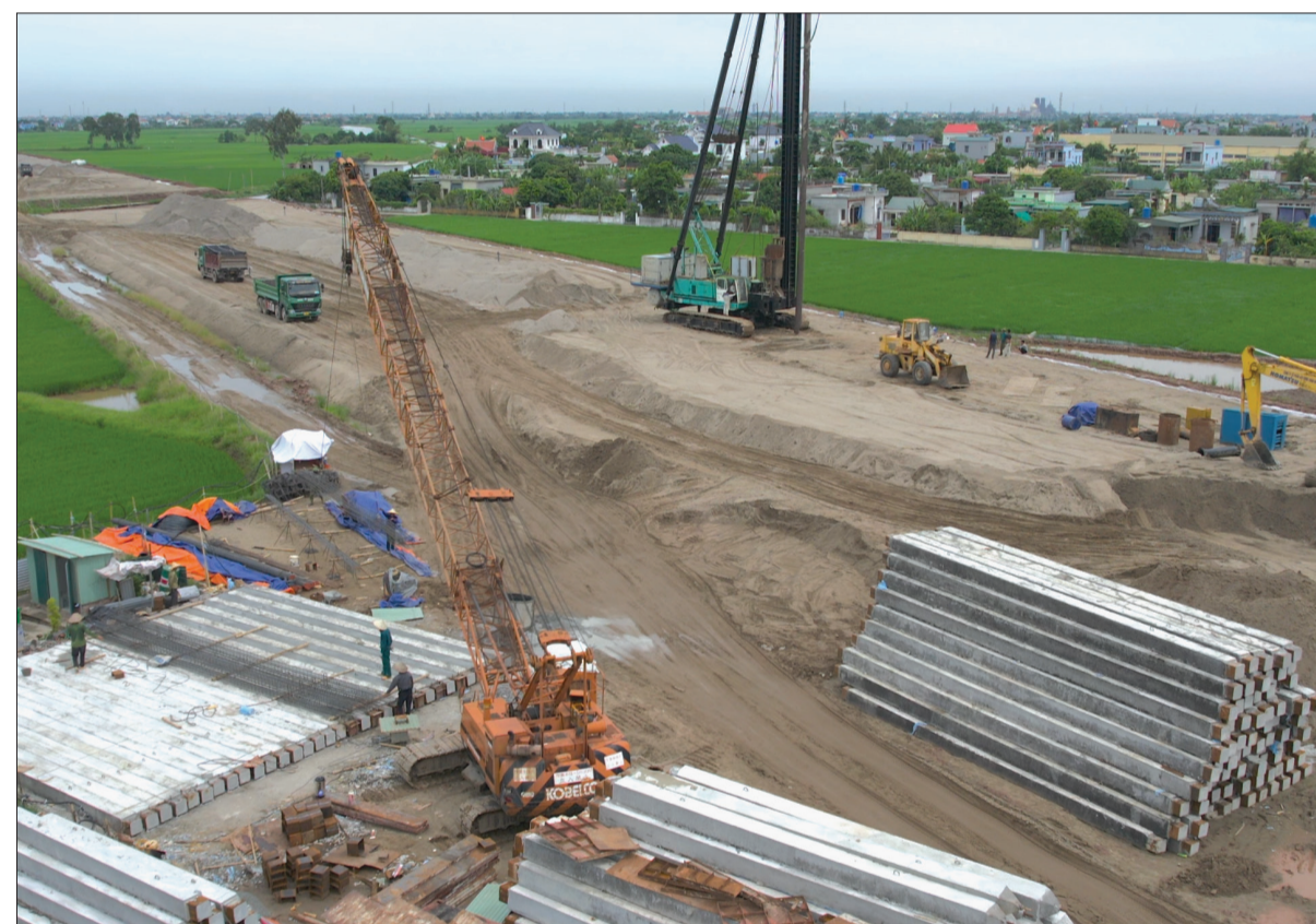
Thi công tuyến số 3 thuộc tuyến đường trục kết nối Khu kinh tế tại huyện Tiên Hải.
