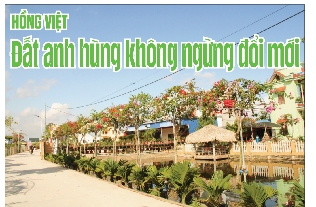
Đường nông thôn mới xã Hồng Việt được bê tông rộng rãi, tràn ngập sắc hoa.
