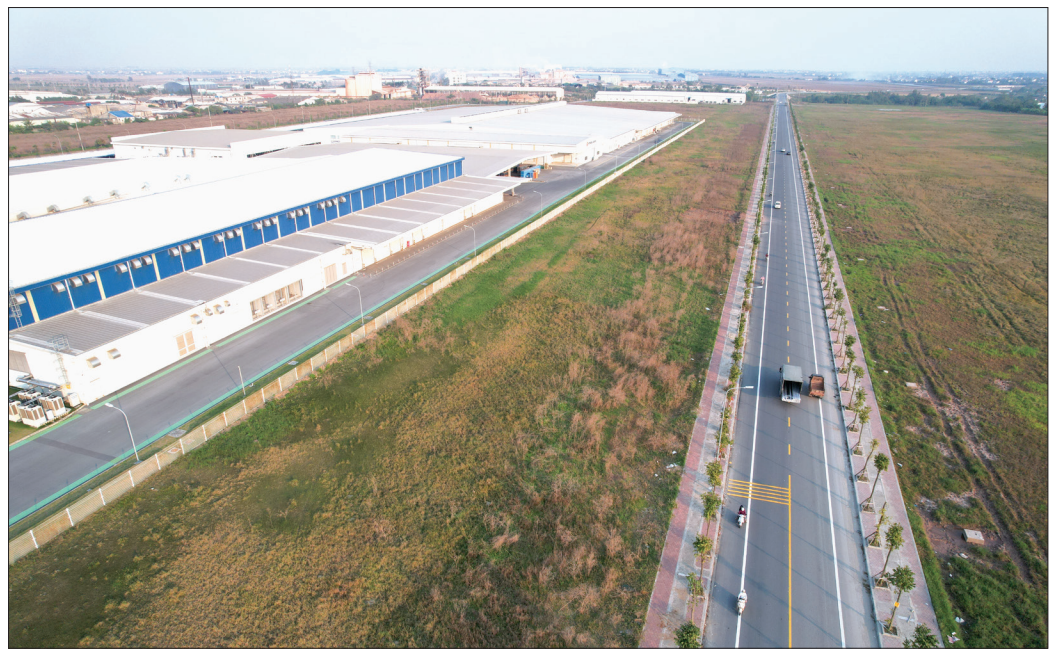
Tuyến đường 221A hoàn thành và đưa vào sử dụng góp phần thúc đẩy kinh tế - xã hội phát triển.
