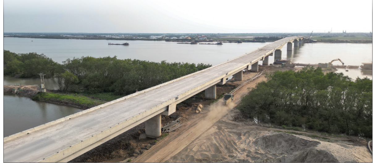
Dự án tuyến đường bộ ven biển đoạn qua tỉnh Thái Bình phấn đấu hoàn thành cuối năm 2025 góp phần thúc đẩy tăng trưởng của ngành xây dựng.
