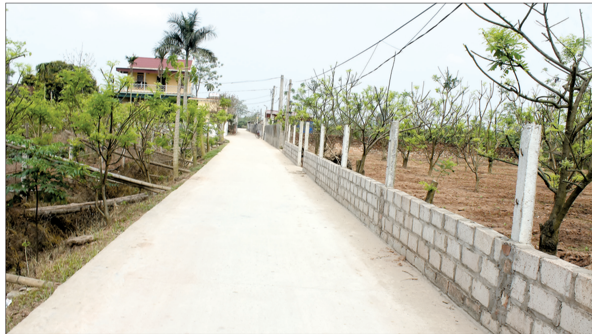
Tuyến đường trục thôn ở xã Hồng Lý (Vũ Thu) mới được xây dựng.
