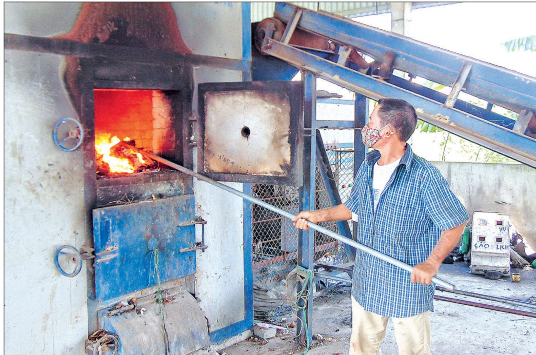
Rác thải được xử lý bằng công nghệ lò đốt tại xã Minh Hòa (Hưng Hà).
