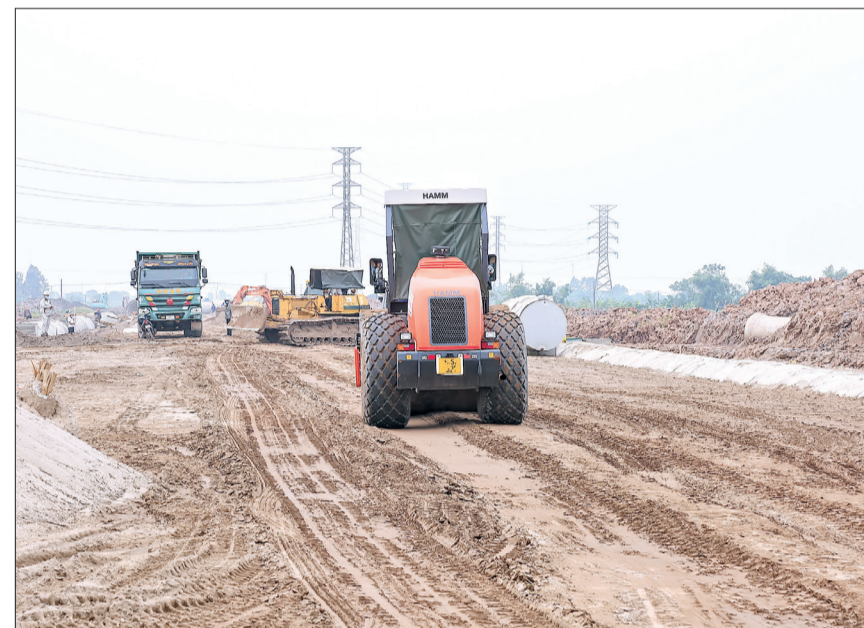
Hạ tầng khu công nghiệp Liên Hà Thái đang được thi công.
