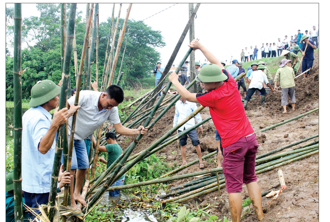
Diễn tập công tác hộ đê tại xã Nguyễn Xá (Vũ Thư).
