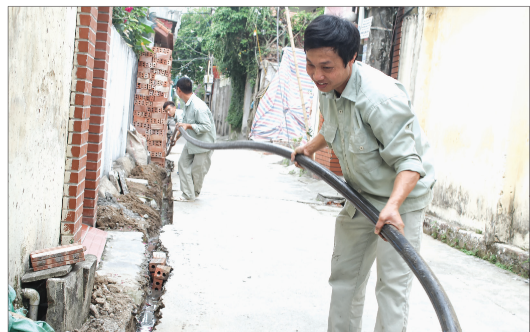
Xí nghiệp nước Vũ Thư tiến hành thay thế đường ống kèm đã xuống cấp bằng ống nhựa HDPE trên địa bàn thị trấn Vũ Thư.
