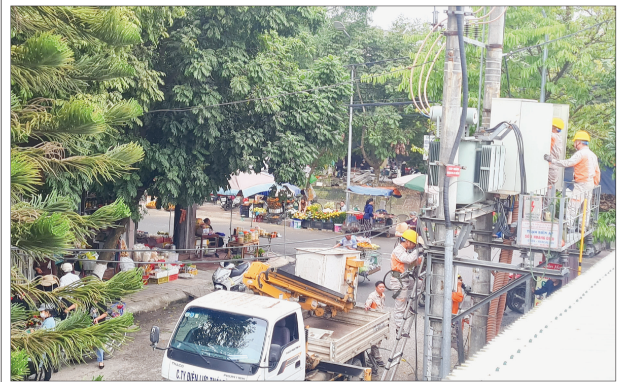
Điện lực thành phố tổ chức nâng cấp, sửa chữa trạm biến áp tại đường Hoàng Diệu.
