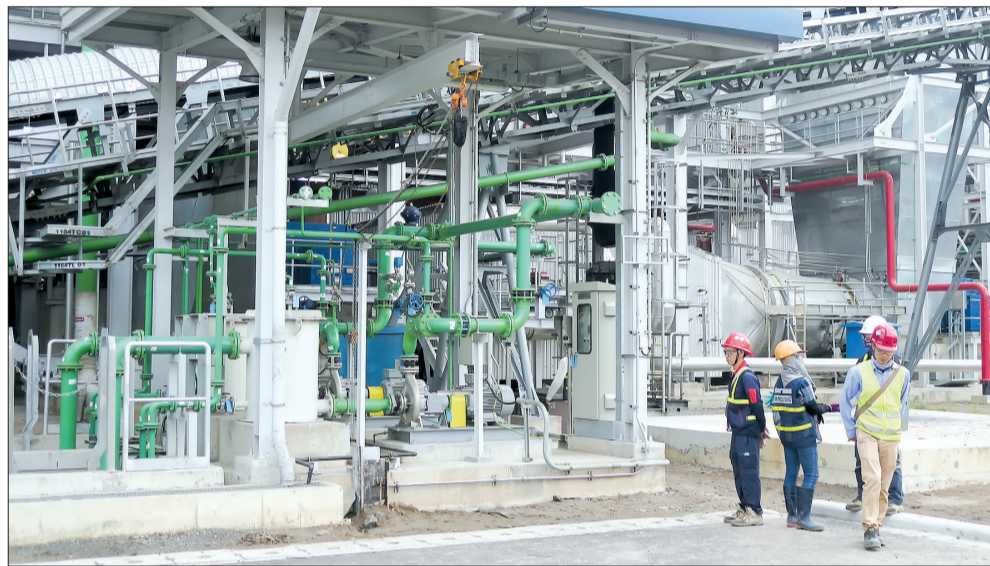
Nhà máy nhiệt điện Thái Bình.
