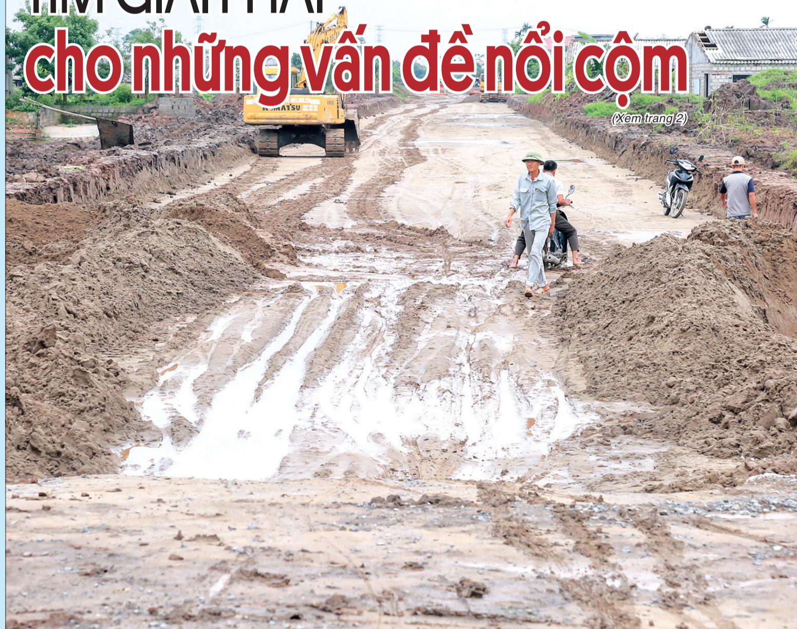
Thi công đường dẫn lên cầu La Tiến.
