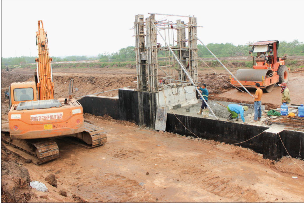
Thi công cống Mai Diêm (thị trấn Diêm Điền).
