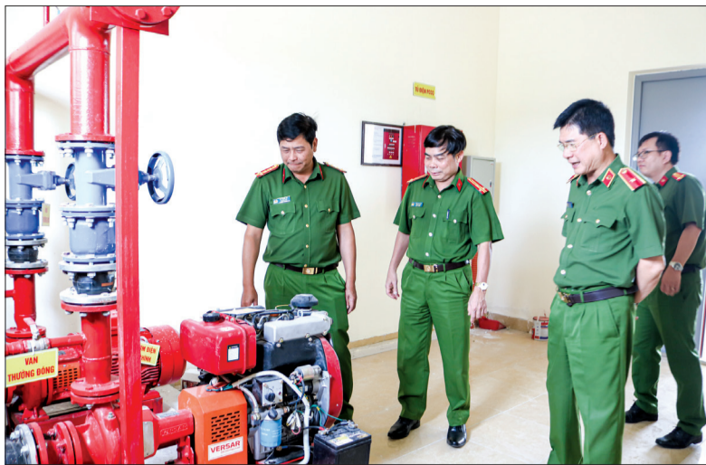
Kiểm tra trang thiết bị chữa cháy tại Đội Cảnh sát phòng cháy, chữa cháy và cứu nạn, cứu hộ khu vực Thái Thụy.
