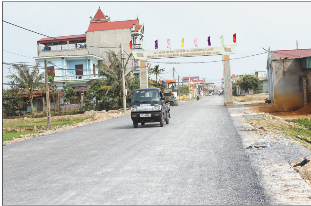
Tuyến đường ĐH.95B đoạn qua xã Thụy Phúc (Thái Thụy) được nâng cấp, mở rộng.
